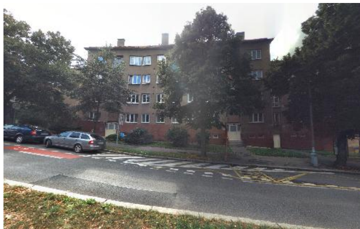
Sídlo Pražského projektového ústavu v Jeremenkově ulici 1021/70
