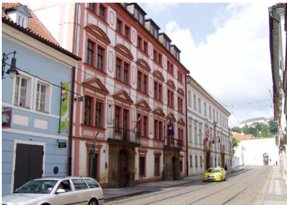
Windischgrätzovský palác v Letenské ulici číslo 3 někdejší sídlo Výzkumného ústavu výstavby a architektury
