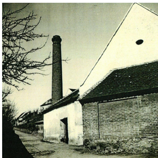
Tovární komín, postavený v roce 1903, byl prvním zděným továrním komínem ve městě
