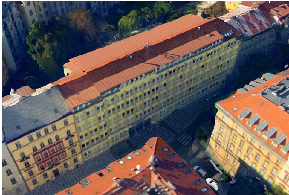
Budova školy v Sázkavské ulici na pražských Vinohradech, kterou postavil jako stavbyvedoucí Ing. Bohuslav Modrý. Jako specialista tehdejšího Pražského projektového ústavu jsem se podílel na projektu budovy a po několika měsících na stavbu docházel.
