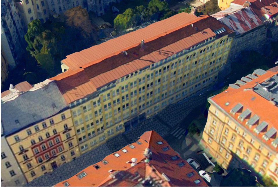
Budova školy v Sázavské ulici na pražských Vinohradech, kterou postavil jako stavbyvedoucí Ing. Bohuslav Modrý. Jako specialista tehdejšího Pražského projektového ústavu jsem se podílel na projektu budovy a po několika měsících na stavbu docházel.
